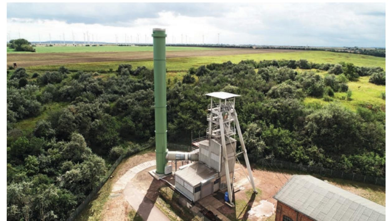
**Abb. 2.2-4** Abwetterkamin am Schacht Halle des Bergwerkes Teutschenthal (Quelle: GTS-Grube Teutschenthal Sicherungs GmbH & Co.KG)
