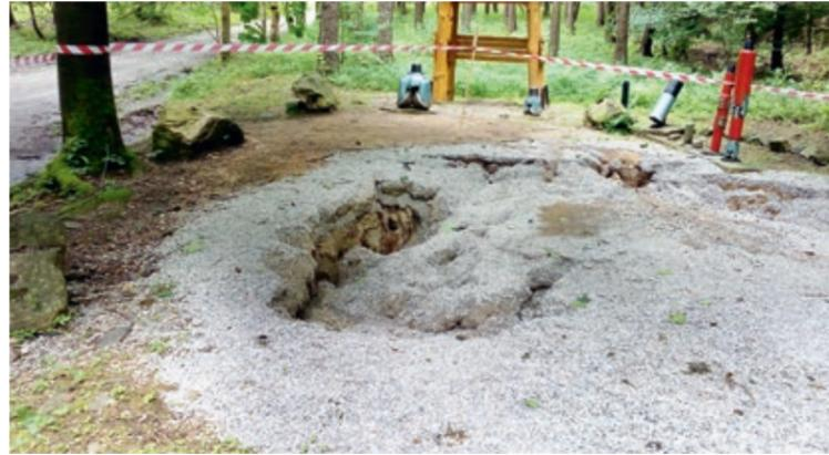
Abb. 2.4-1 Erstsicherung des Verbruches des Schachtes „Bergmanns Hoffnung“ (Quelle: LAGB)
