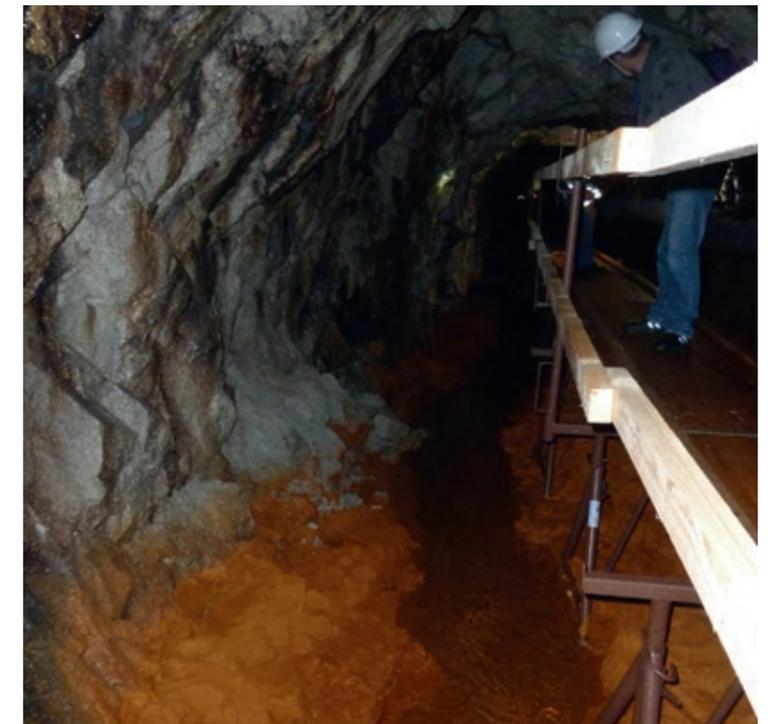
Abb. 2.4-4 Wasserführender Hagentalstollen nach Zugänglichkeit mit Tretwerk (Quelle: LAGB)
