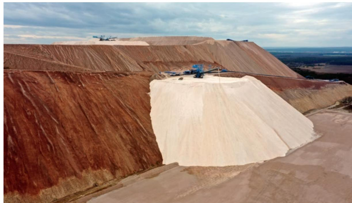
Abb. 2.5-1 Haldenkomplex Halde 2/HKE/HKE II – erste Rückstandsschüttung auf die basisabgedichtete Fläche der HKE II (Quelle: K + S Minerals and Agriculture GmbH, Werk Zielitz)
