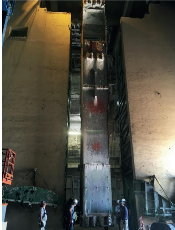
**Abb. 2.2-3** Demontage des Fördergefäßes mittels Gefäßwechselkran, (Quelle: Herr Herrmann, K+S Minerals and Agriculture GmbH, Werk Zielitz)
