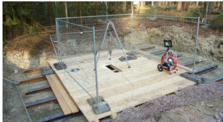
Abb. 2.4-3 Kamerabefahrung des Überhauens 105 im Vorfeld der Verfüllung (Quelle: LAGB)
