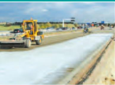
Oberbeton gleichzeitig eingebaut werden. Nach der Verdichtung des Unterbetons werden Dübel und Anker in den Beton eingerüttelt. Der Einbau des Oberbetons mit dem zweiten Fertigungskomplex erfolgt mit einem Vorderbeschicker, einer Art Transportband, über den Unterbeton hinweg. Abschließend wird der Beton geglättet.
