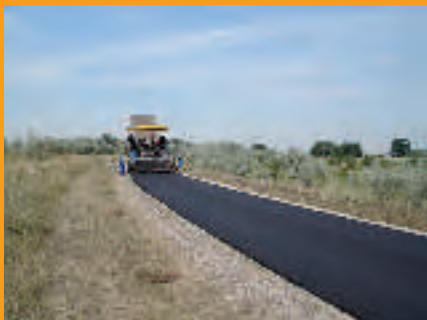
Bau eines Rad- und Skaterweges
