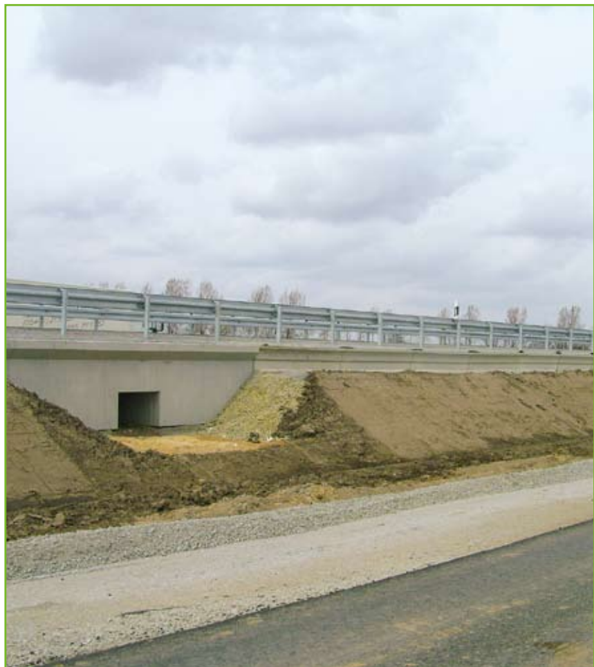
Seitenansicht nach Abschluss der Bauarbeiten.
