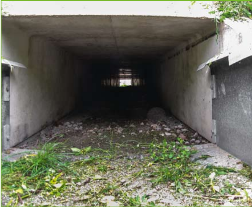
„Tunnelblick“ aus Sicht der querenden Amphibien (hier eine Anlage an der B 188 bei Solpke). Maßgeblich für die Akzeptanz der Tunnel ist der Lichteinfall am gegenüberliegenden Tunnelausgang.
