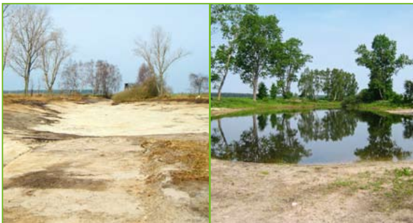
Fertige Profilierung und Endzustand als Gewässer
