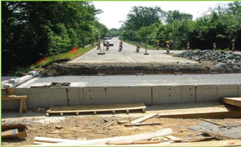
Baustelle Wildkatzendurchlass 2011, mit ampelgeregelter Umfahrung. Im September 2011 waren die Bauarbeiten abgeschlossen.
