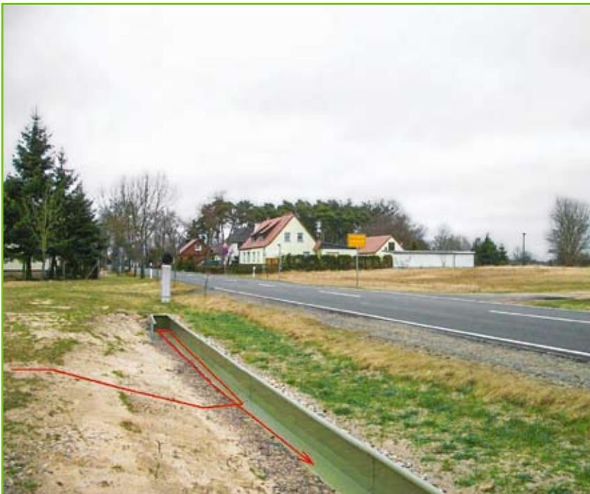
Schleifen- oder U-förmige Enden der Leitelemente lenken Tiere am Ende der Leitwände wieder in Richtung der nächsten Tunnel (L 31 bei Bölsdorf).
