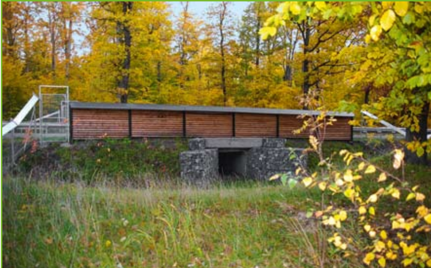
Ein Wildkatzendurchlass nach der Fertigstellung. Der Blendschutz oberhalb des Durchlasses hat eine Länge von 15 m und ist ebenso wie der Schutz- und Leitzaun mit einem Überkletterungsschutz ausgestattet.
