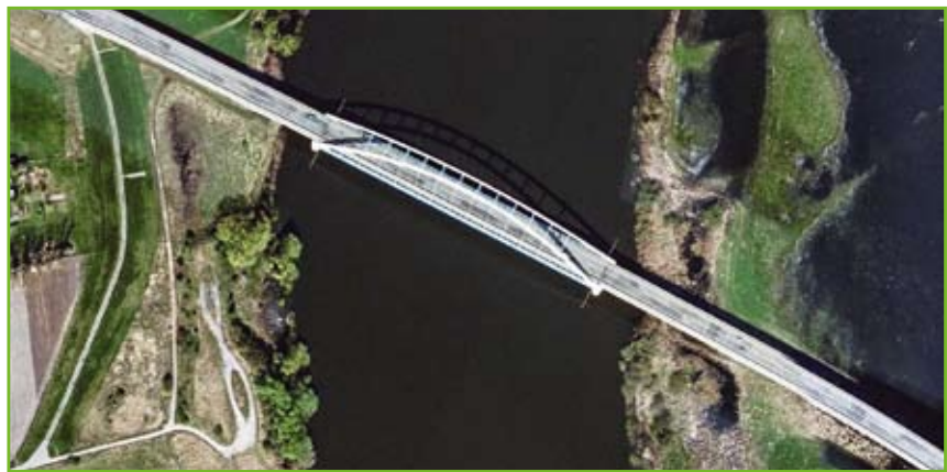
Der schiffbare Elbstrom wird von einer schlichten, in Weiß und Blau gehaltenen Stabbogenbrücke überspannt. Das Landschaftsbild wird dadurch möglichst geringfügig verändert. Das massive Eisengestänge in den Brückenfeldern kann von Vögeln vermutlich wahrgenommen werden; wissenschaftliche Untersuchungen sollen dazu beitragen das Fachwissen zur Thematik Vogelschlag an Brückenbauwerken zu vertiefen.
