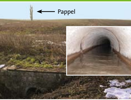
Vorher: der Harsleber Bach im verrohrten Zustand
