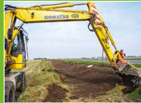
Vor Baubeginn wird der Oberboden abgetragen und nach Hamsterbauen gesucht.
