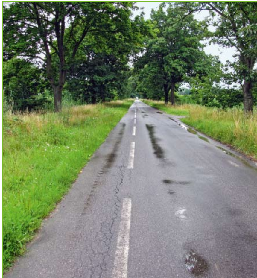
Rückbau der K 1031, die von Fischbeck in die Elbaue führt. Sie Straße erfüllt keine Verbindungsfunktion zwischen Ortschaften und dient nur noch als Zufahrt für die Unterhaltungsarbeiten am Elbdeich, die anliegenden Wiesenbewirtschafter und natürlich zur touristischen Nutzung durch Radler und Wanderer.
