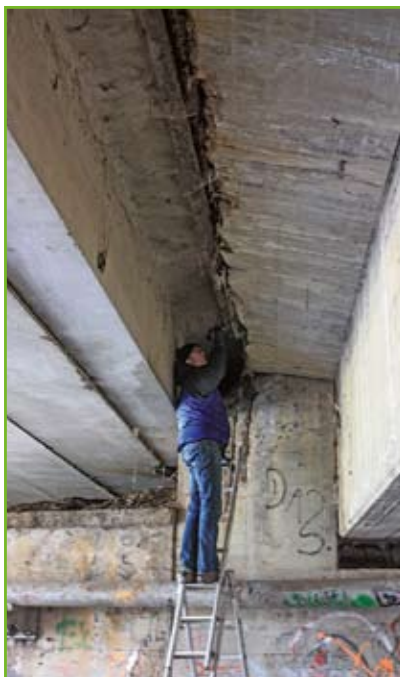
Absuchen eines Brückenbauwerks nach Fledermäusen vor den Sanierungsarbeiten.
