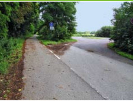
Entsiegelung der alten Ortsdurchfahrtsstraße am Ortsausgang Weteritz nach Neubau der Ortsumfahrung im Zuge der B 188/L 25. Ein alter Fahrstreifen verbleibt als Geh- und Radweg.
