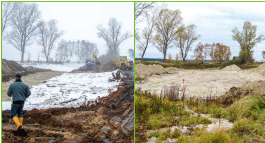
Aushub- und Profilierungsarbeiten
