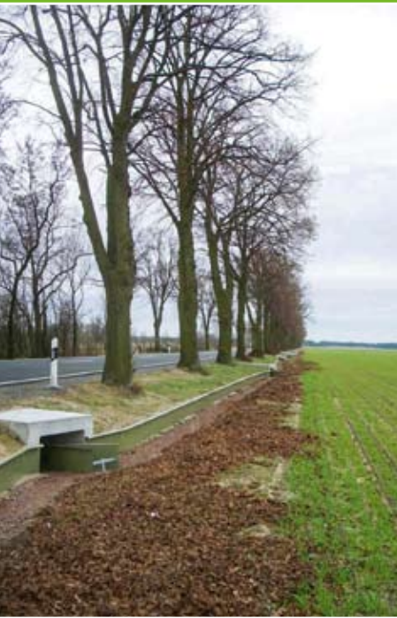
Amphibienquerungshilfe südlich von Bölsdorf (bei Tangermünde). Der Einbau der Querungshilfen wurde mit einer Sanierung der Fahrbahn verbunden.
