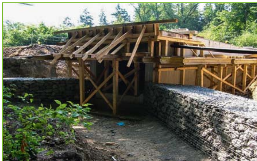
Baustelle Wildkatzendurchlass 2011, zukünftige „Katzen-Perspektive“.
