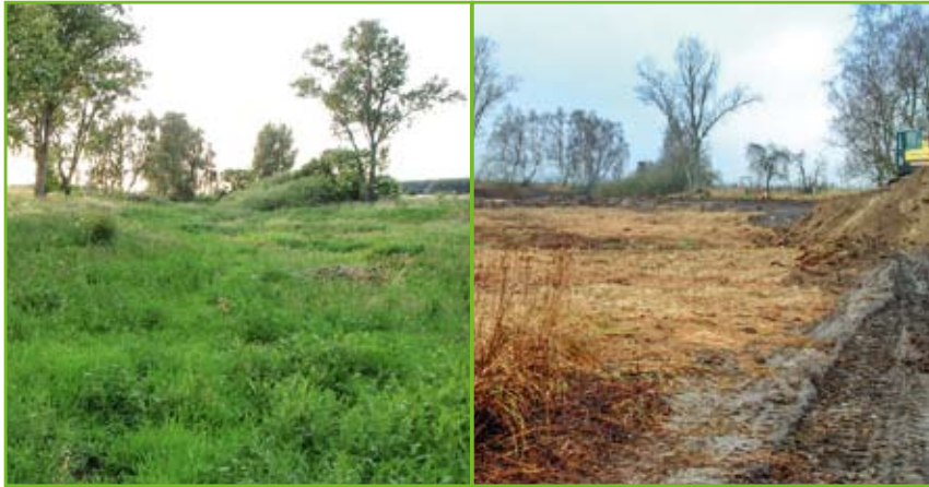
Ausgangszustand und Beginn der Bauarbeiten
