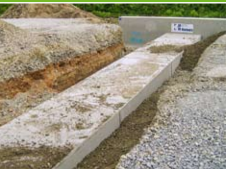
Blick von oben auf einen Tunnel während des Einbaus. Darüber werden die Trag- und Deckschichten der Fahrbahn gezogen.
