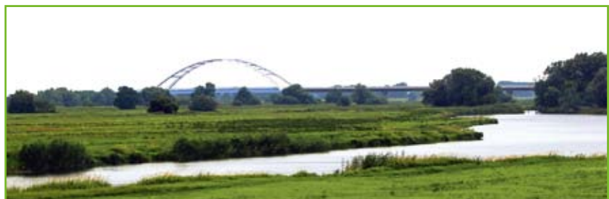
Strombrücke und ein Teil der Talbrücke über den Auenbereich, ein Altarm der Elbe im Vordergrund.
