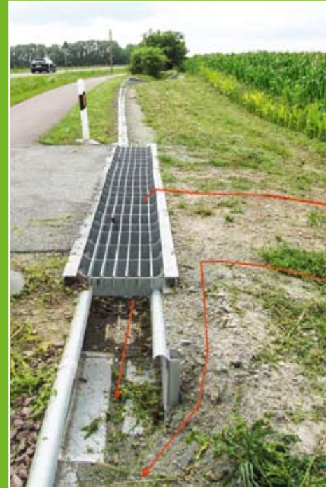
An Einmündungen von Wegen auf die Straße werden sogenannte Stopprinnen eingebaut. Die Gitter stellen einen unattraktiven Untergrund für Amphibien dar. Wegen die Tiere dennoch eine Überquerung, fallen sie durch die Gitter und landen wieder an der Leiteinrichtung. (Anlage B 188 bei Solpke)
