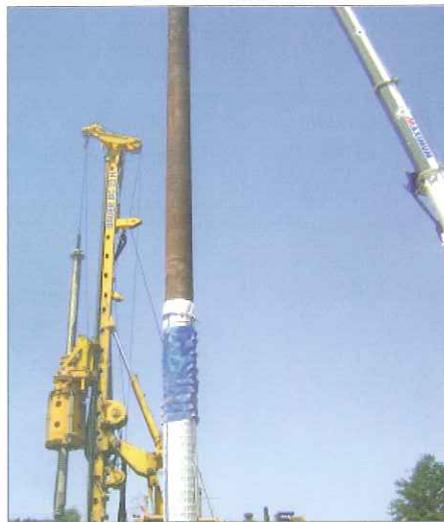
BW 6A; Mit „Bullflexschlauch“ überzogenes Hüllrohr
