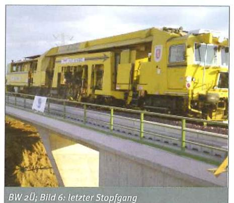
Das eigentliche Betonbrückenbauwerk wurde 25 Meter neben dem Bahndamm in einer separaten Baugrube errichtet und nach seiner Fertigstellung komplett in einer 72-stündigen Sperrpause quer in den Bahndamm verschoben. Im Anschluss erfolgte die verkehrssichere Wiederherstellung des Bahndamms und der Gleisanlagen (Bilder BW zÜ; 1 bis 7).
