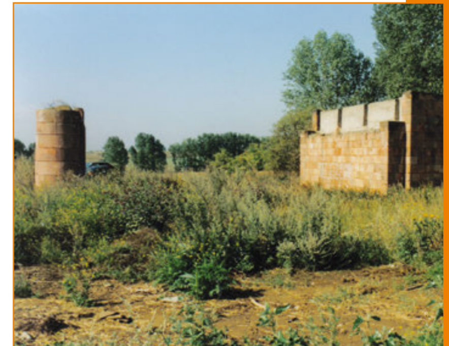
Reste der in den 1930ern begonnenen Autobahntrasse bei Irxleben.
