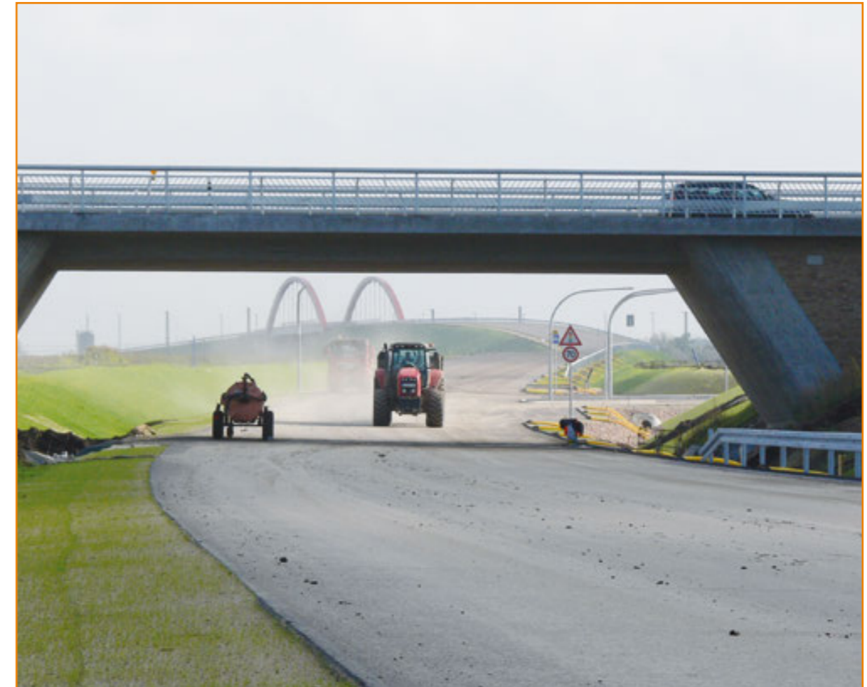
Baustelle der B 6n bei Bernburg.
