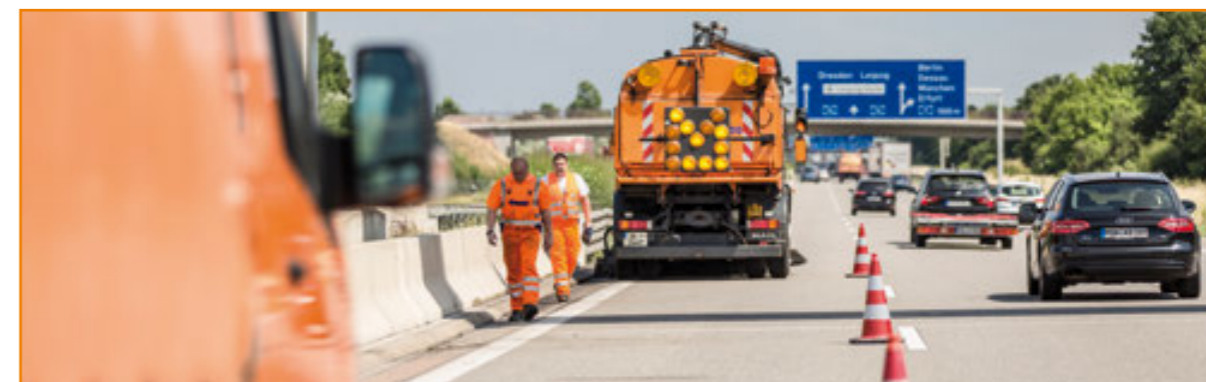
Zeitweise Verkehrseinschränkungen auf den Autobahnen durch Bau- und Instandhaltungsarbeiten gehören zum Alltag.
