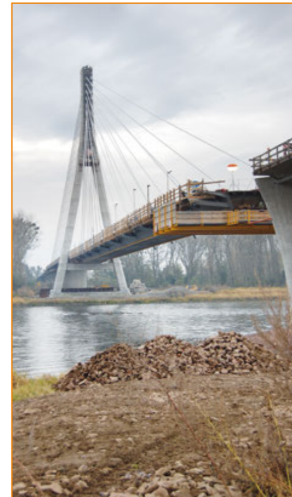
Der Einbau des Verbindungsteils ist der spannendste Moment bei jedem Brückenbau.
