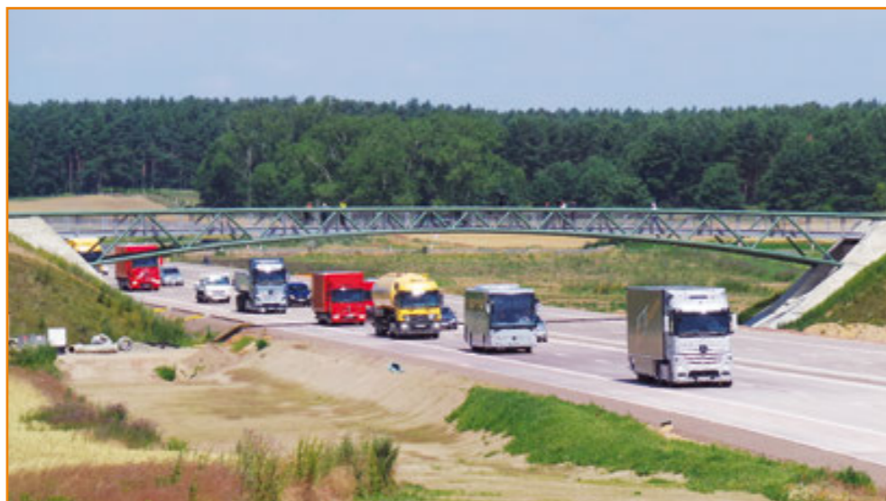
Wie sich die neue Autobahn anfühlt, konnten die Testfahrer bei der Mercedes-Benz-Veranstaltung bereits erleben.
