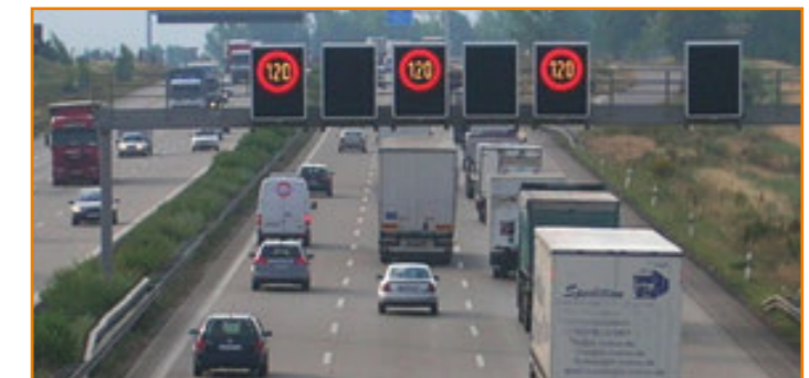
Tag und Nacht tragen die Mitarbeiter der Verkehrsmanagementzentrale dazu bei, die Straßen Sachsens-Anhalts ein Stück sicherer zu machen. Die Streckenbeeinflussungsanlagen auf der Autobahn 2 gingen im Jahr 1998 in Betrieb. Insgesamt 20 Anzeigequerschnitte (Schilderbrücken) gibt es hier.
