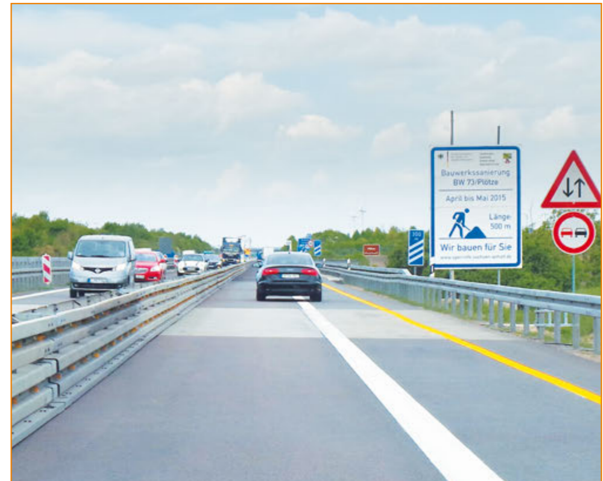
Baustellenverkehrsführung im Zuge einer Bauwerkssanierung auf der A 14
