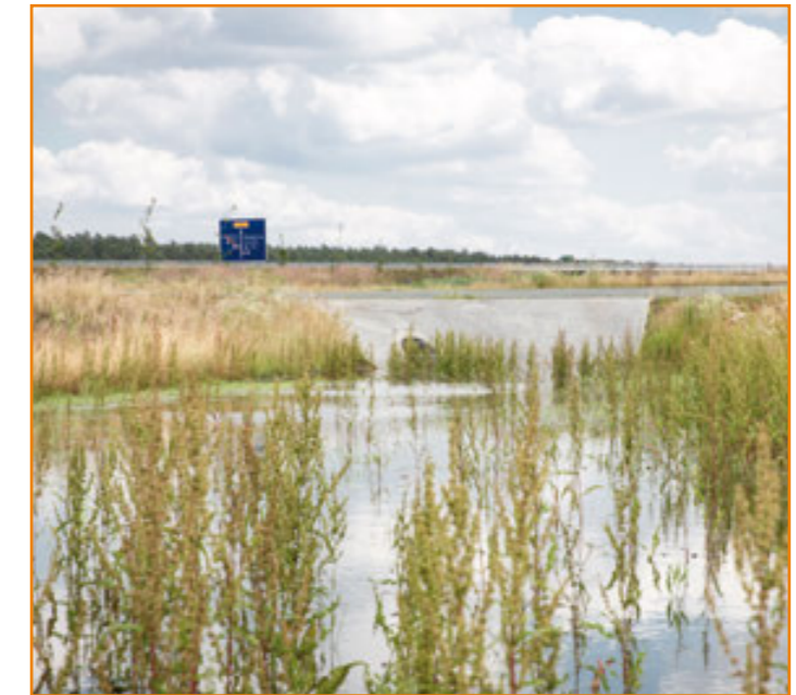
Entwässerungsbecken und Ausgleichsmaßnahmen nehmen das Regenwasser auf.
