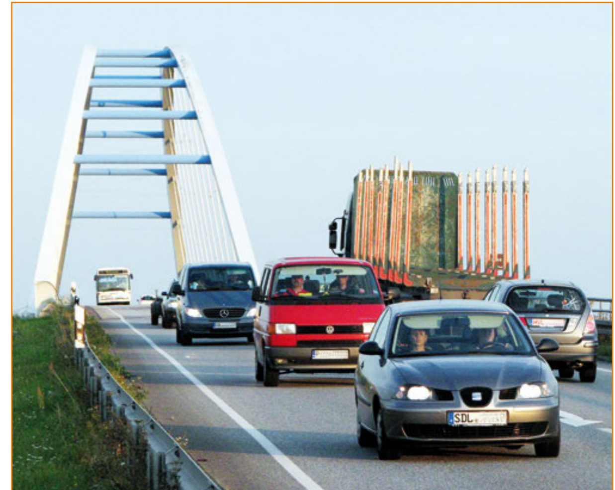
Die Elbebrücke der B 188 bei Tangermünde.
