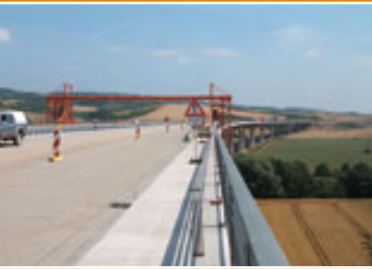
Bau der Thyrtalbrücke an der A 38
