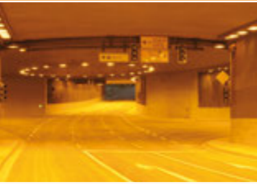
Der Altstadttunnel Wernigerode
