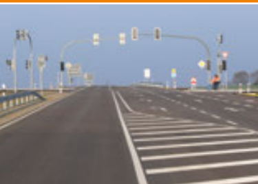
Ein fertig gestellter Abschnitt vor der Verkehrsfreigabe.
