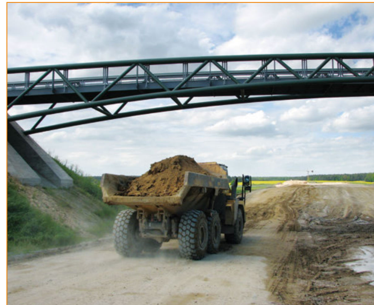
Großprojekte, wie der A 14-Lückenschluss (hier die Bauarbeiten bei Colbitz) sind heute die Ausnahme.
