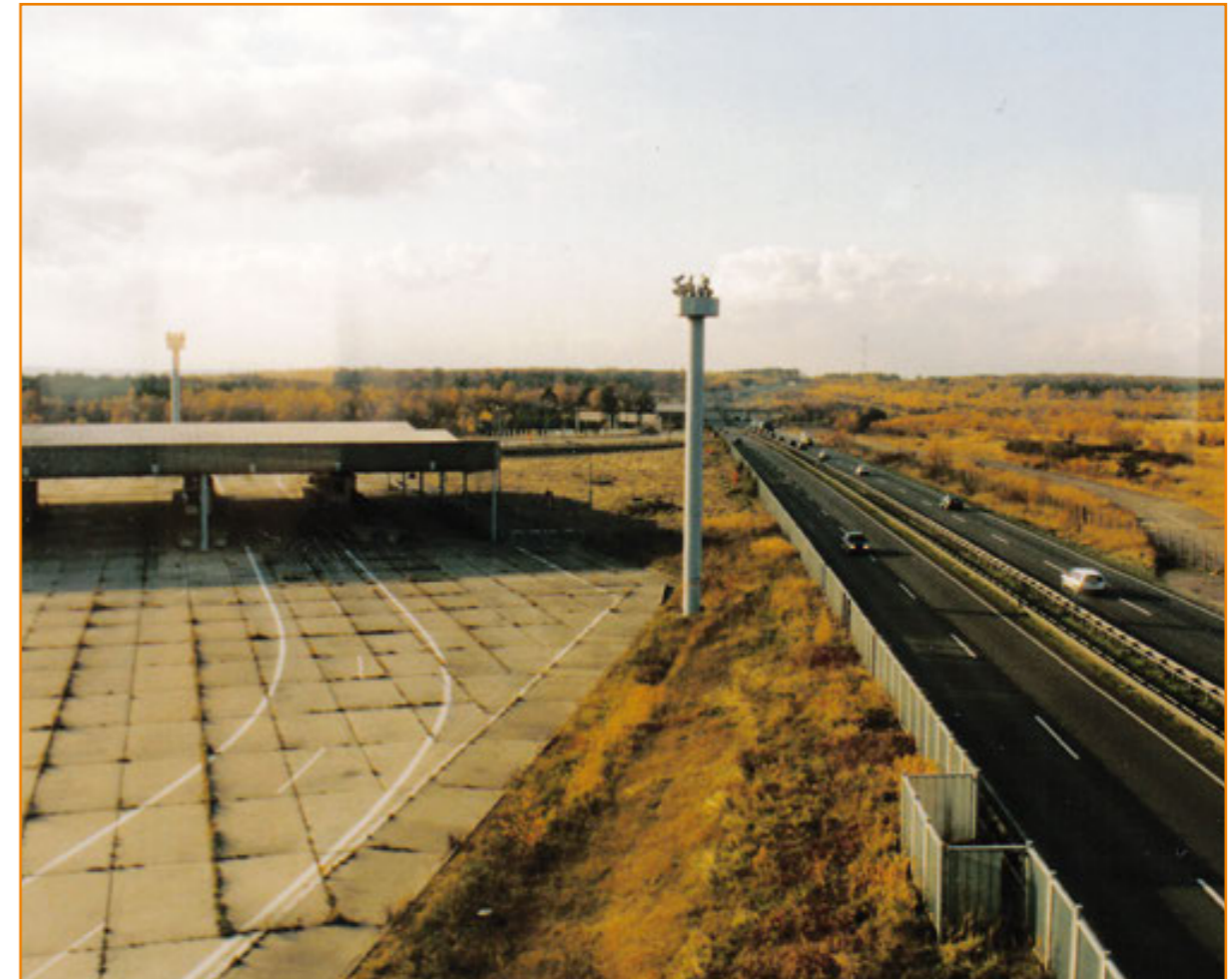
Die A 2 bei Marienborn vor dem sechsstreifigen Ausbau.
