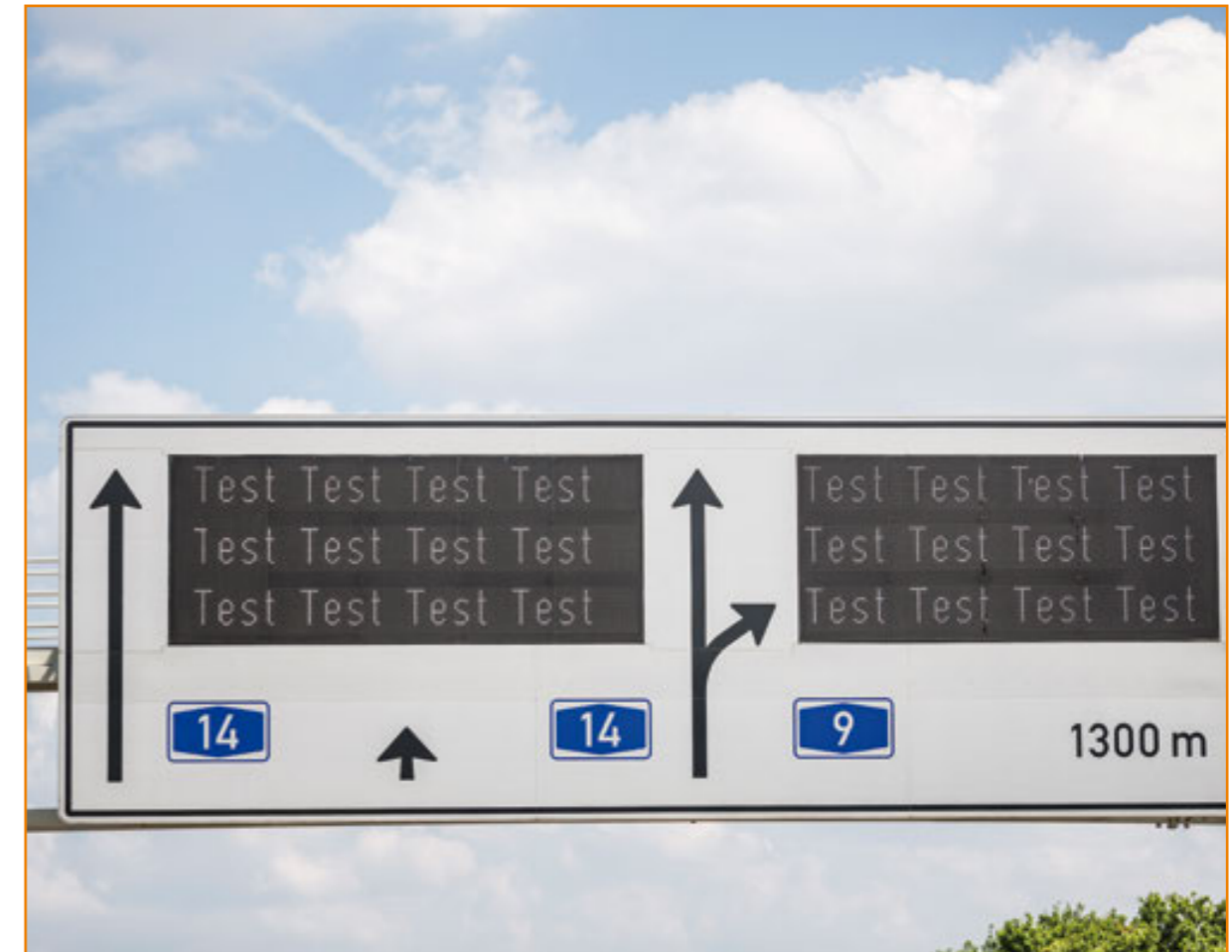
Im Bereich des Autobahnringes Halle/Leipzig wurde die Netzbeeinflussungsanlage als Gemeinschaftsprojekt der Länder Sachsen-Anhalt und Sachsen sowie der Stadt Leipzig eingerichtet. Sie ist seit 2006 in Betrieb.
