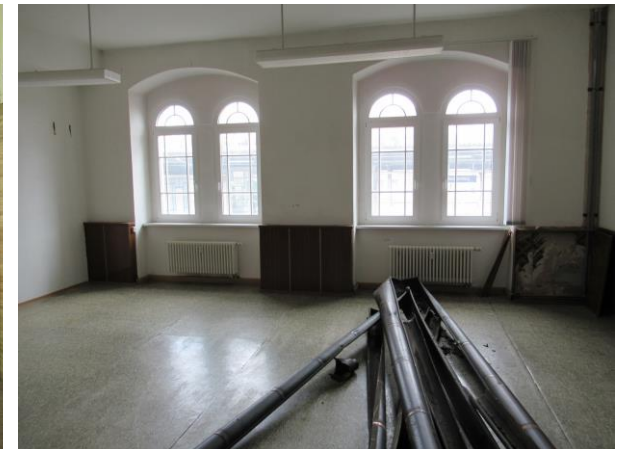
Innenräume im Obergeschoss
