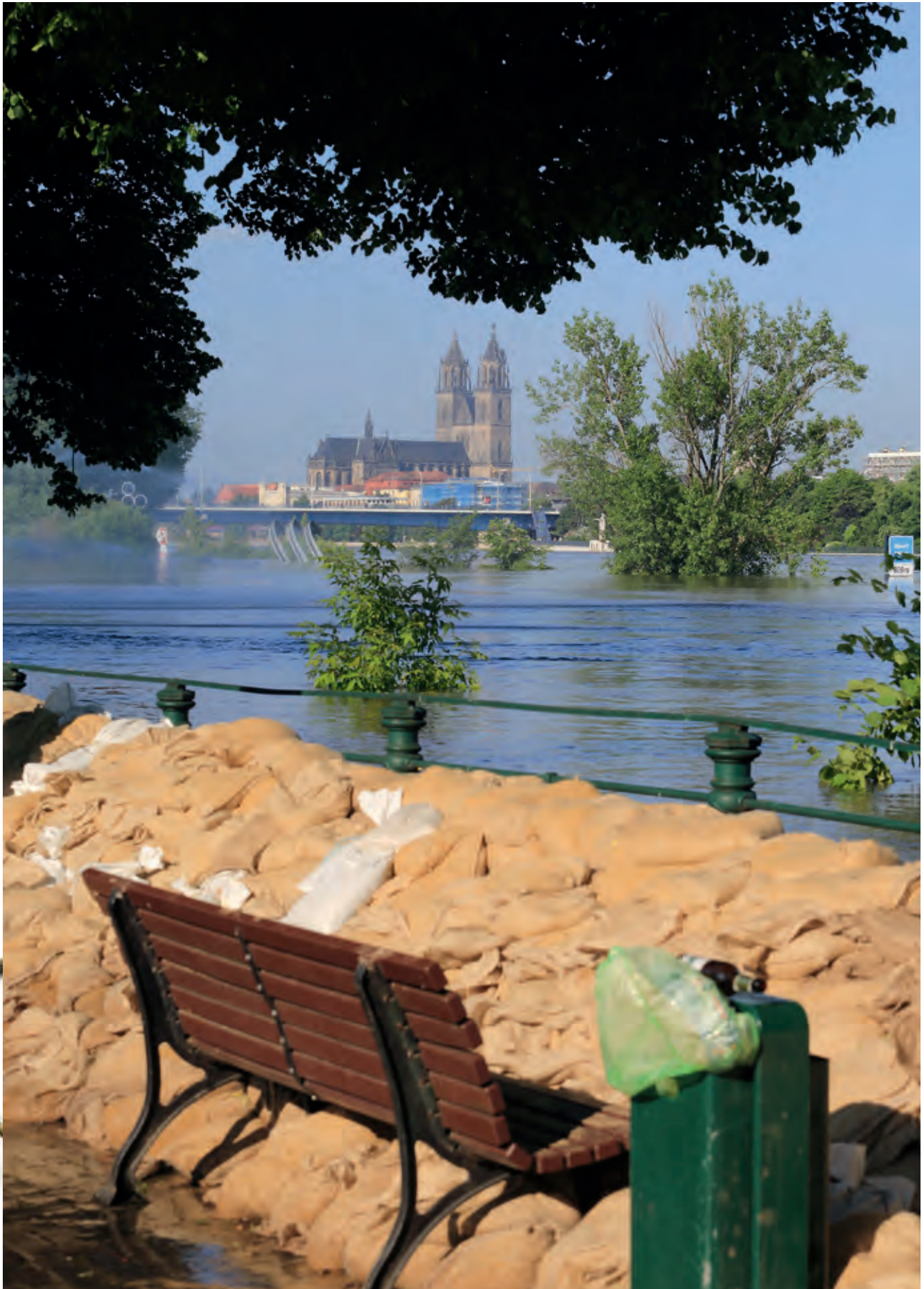
Elbehochwasser 2013 in Magdeburg infolge einer Wetterlage mit ungewöhnlich hohen Dauerregenmengen
